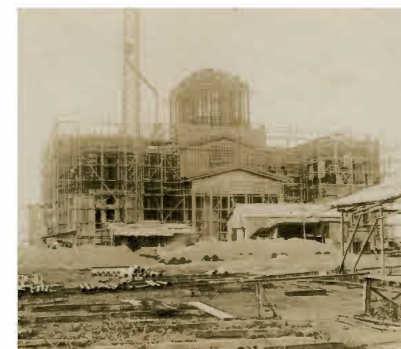
建設中の大倉精神文化研究所本館 (現在の横浜市大倉山記念館)
